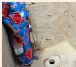
実際のトイレ内部
